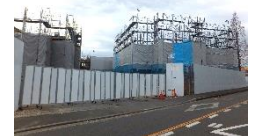
現在の工事風景
